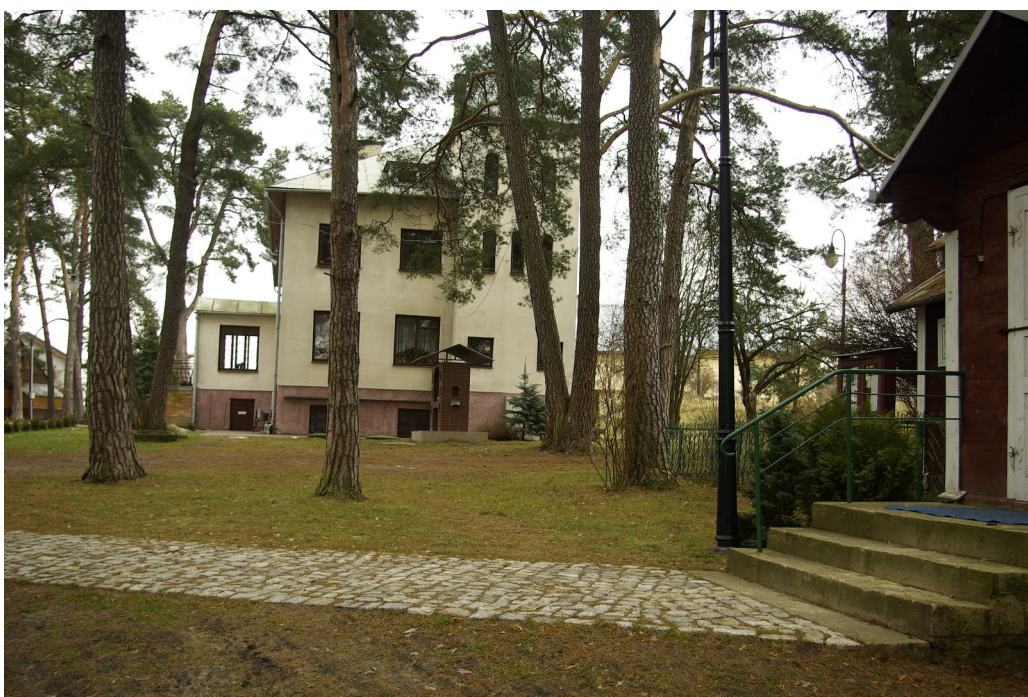
Obecnie znajduje się tu budynek mieszkalny klasztoru (fot. autorska)
